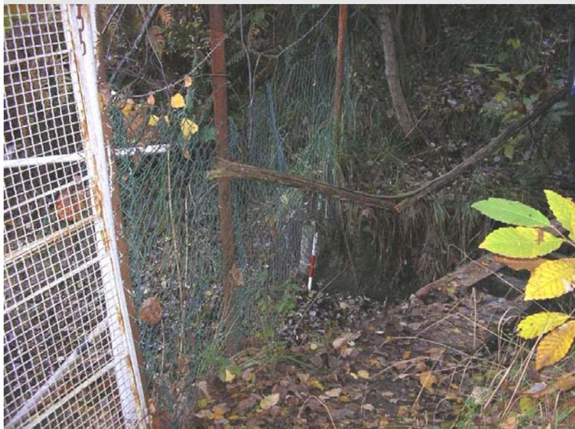
*Foto 2 Sforatore superficiale dell'invaso ostruito dalla presenza della rete di protezione*
